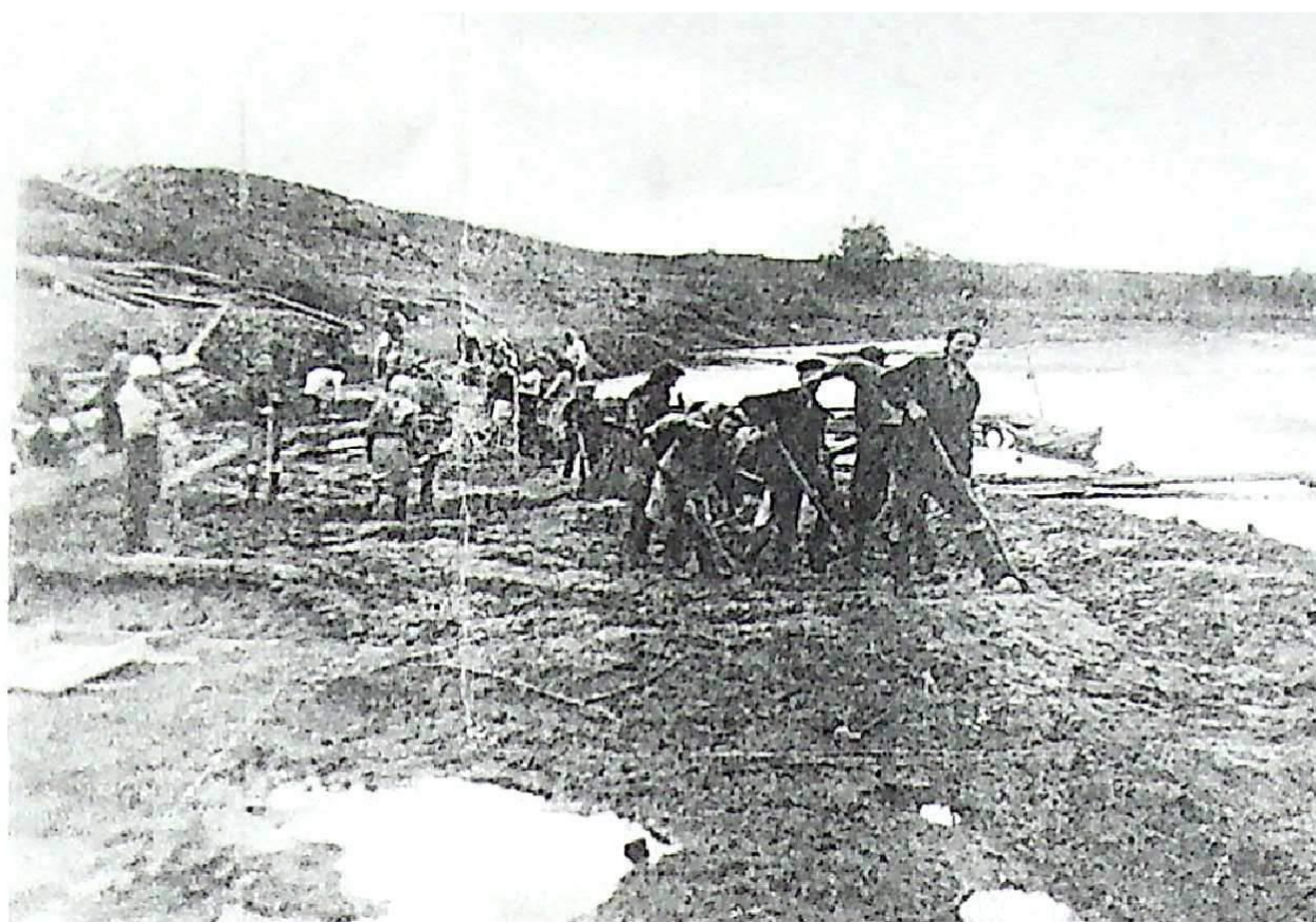
1950-е годы. Жители Знаменского района на строительстве Кондрашинской ГЭС.
