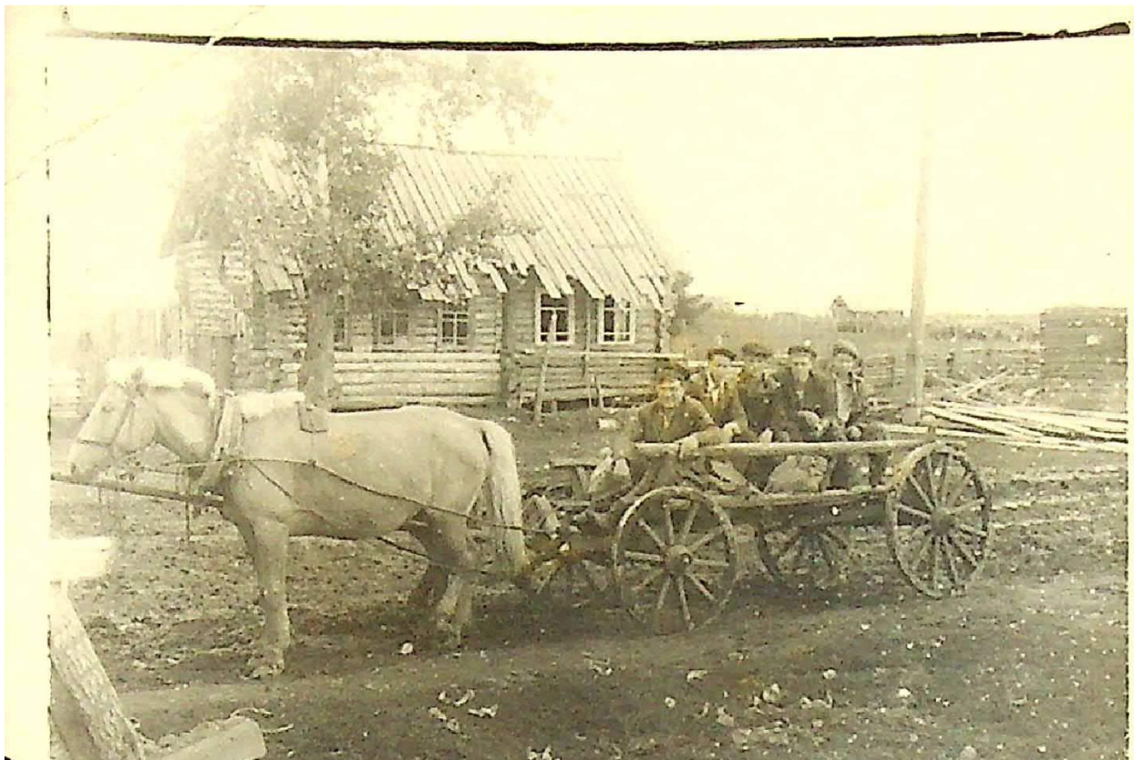
1950-е годы. Жители деревни Слобода у строящегося жилого дома.
